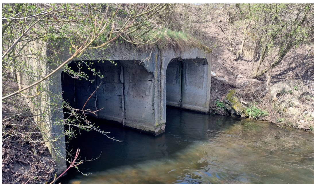
Ervěnický koridor, propustek
