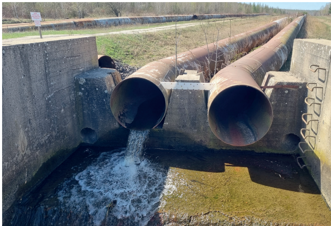
Vyústění potrubí z Ervěnického koridoru
